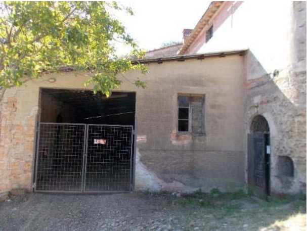
Foto effettuate durante il sopralluogo eseguito il 14/07/2020
